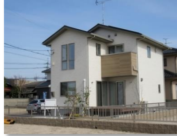
(建物外観:南西から)
